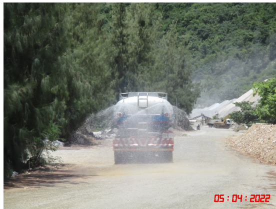
รูปที่ 2-7 การฉีดพรมน้ำภายในพื้นที่โครงการ
